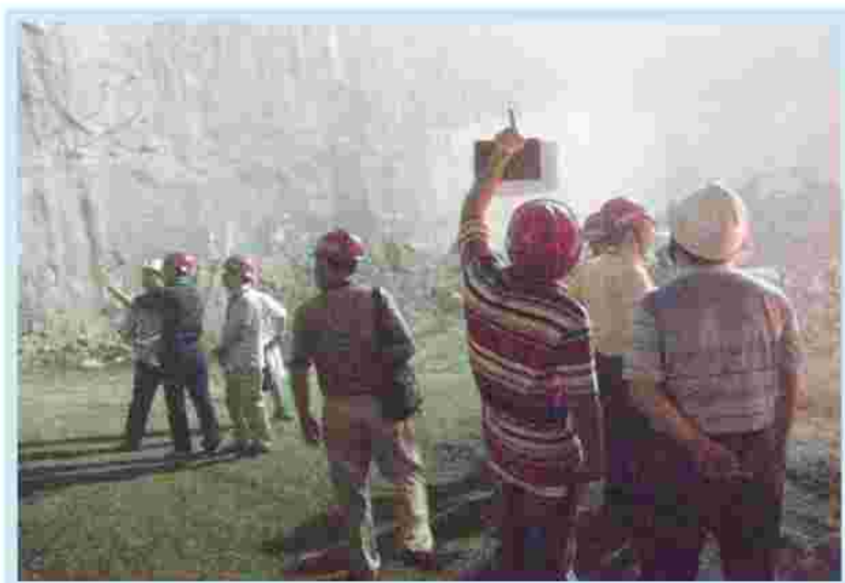
查勘人员在暗挖施工现场
